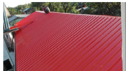
屋根張替え後
